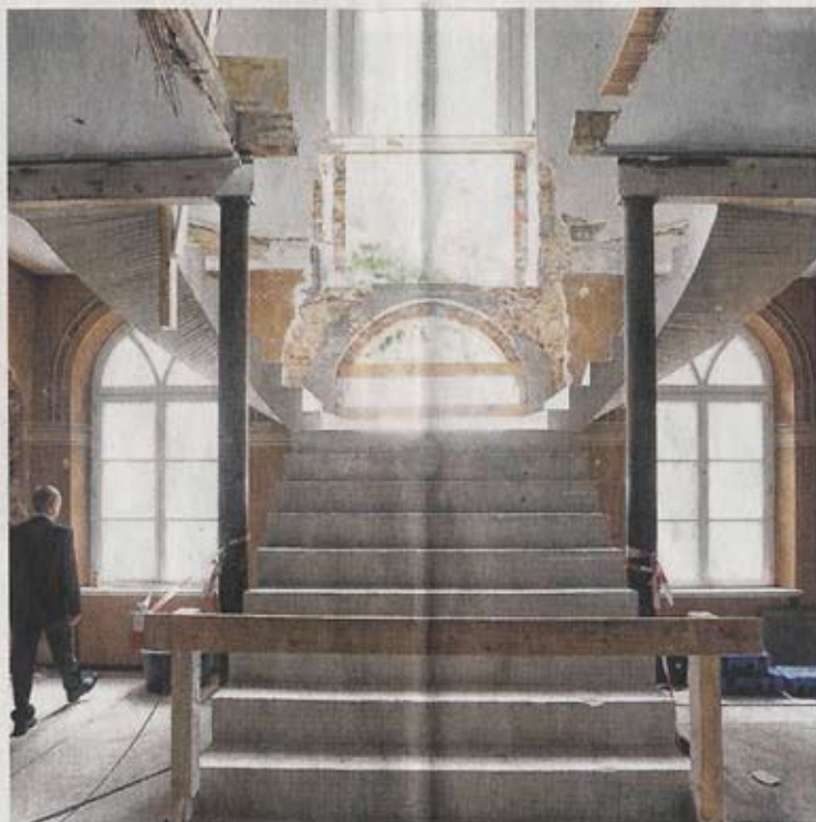
Die rekonstruierte Freitreppe .
